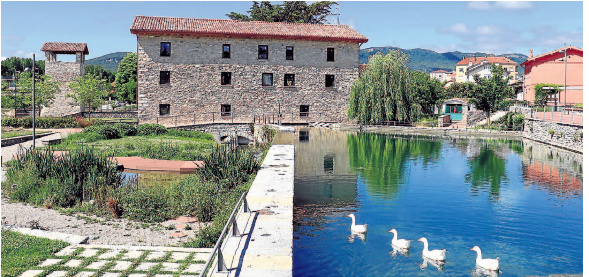
El proyecto de adecuación contemplaba construir un bar, un restaurante y cuatro habitaciones en el molino, cuya planta baja estuvo en desuso desde 1918. :: JESÚS ANDRADE
